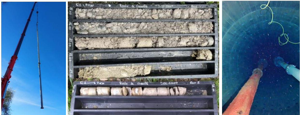
Figure 3 : abaissement de pompes, géologie et exploration dans un puits, source : Eau d'Azur, 2023
