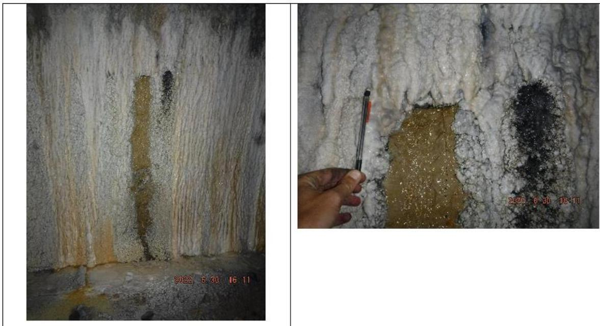
**Figure 6 : Photos de fissures productives affectant la roche affleurant à l'intérieur du tunnel**
