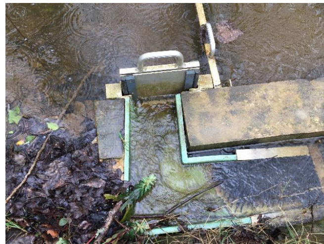
Prise d'eau des Grands Sables réaménagée (seuil, batardeau de réglage du débit réservé et
