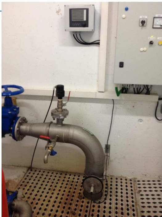
Intérieur local FE3
