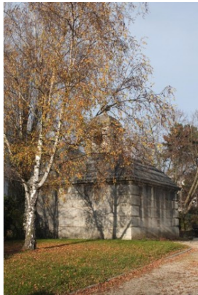
Regard 1 – Aqueduc Médicis (Cerema)
