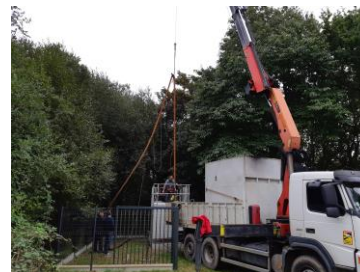
Dépose d'une pompe
