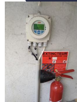
Débitmètre électromagnétique
