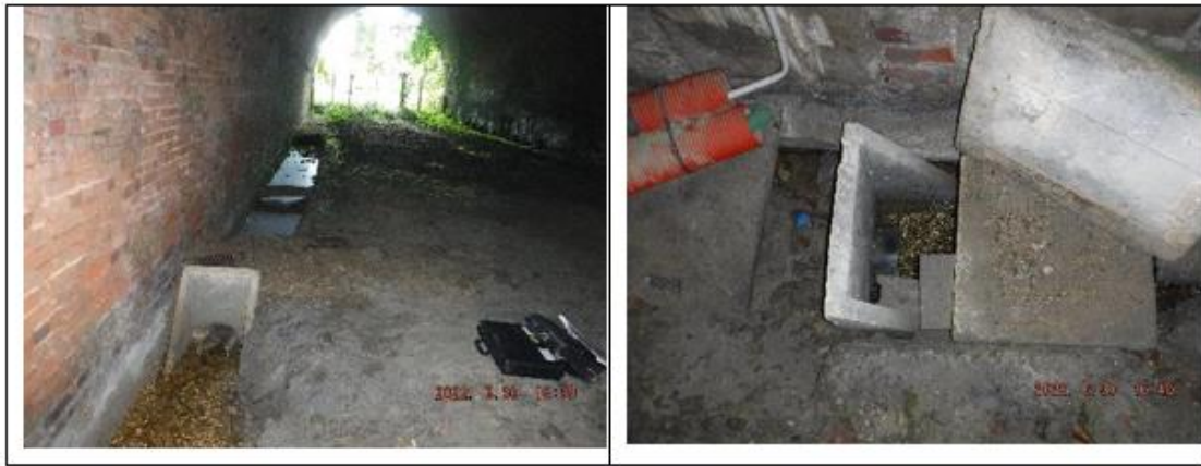
Figure 14 : Photos des prises d'eau aux exutoires des caniveaux Est (gauche) et Ouest (droite)
