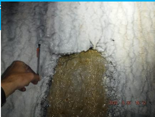
fissures productives affectant la Craie vues depuis l'intérieur du tunnel
